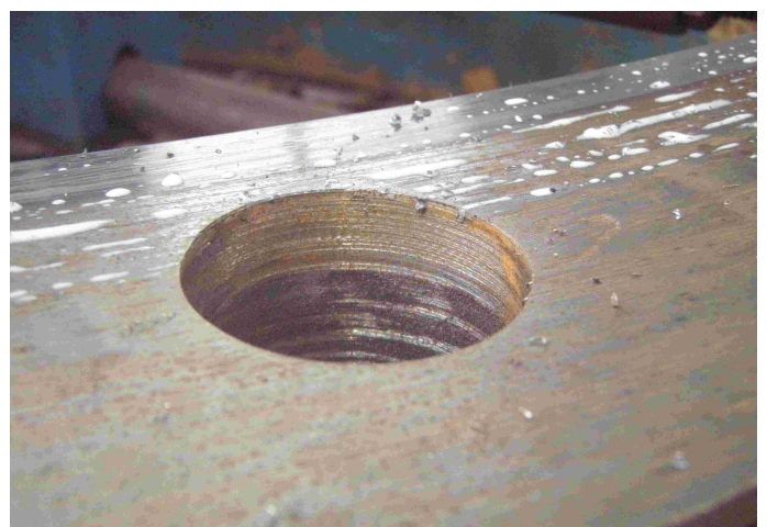
Detalle alojamiento recuperado con VERSAMIL Fuente: P8093444.JPG
